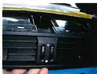
ルーバーを外す
